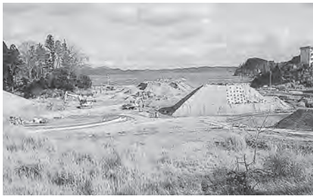
復興道路の建設が進む野々浜地区
